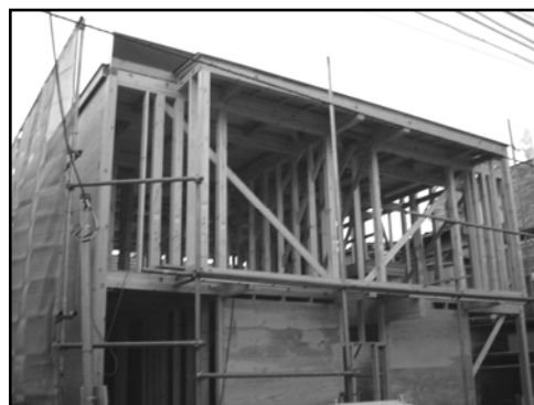
建設中の「やじろべえ」
