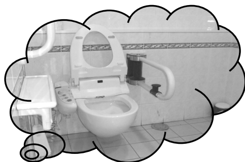
↑トイレの中の様子。
